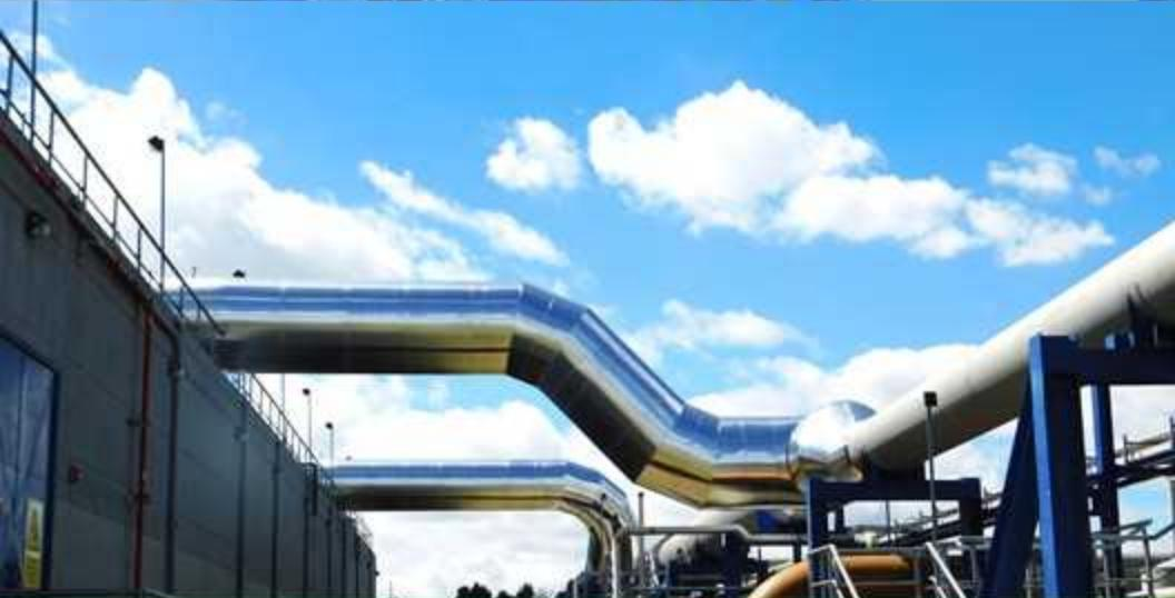
Finalizó el recubrimiento de la tubería de descarga y conducción de aire hacia los reactores biológicos, con material de lámina mineral y de aluminio. Con este recubrimiento se garantiza el aislamiento acústico de los sonidos molestos que se generan por el proceso de inyección de aire, identificados por algunos residentes de los conjuntos residenciales vecinos a la PTAR El Salitre.
