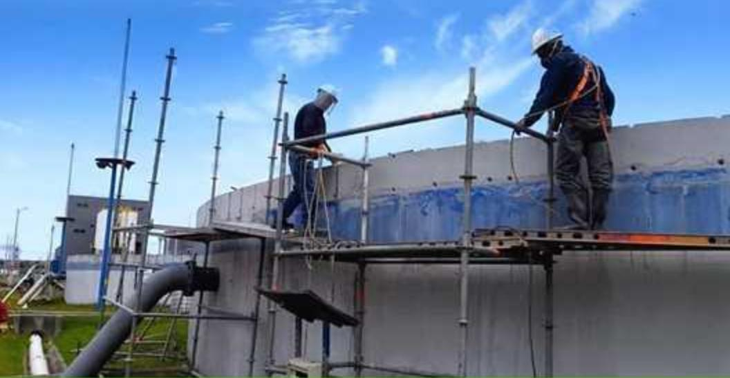
Se llevó a cabo el recalce de las perforaciones realizadas previamente para la instalación de anclajes y acero que permitirán la nivelación para los soportes de la cobertura de fibra de vidrio.
