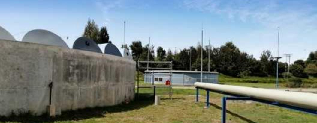
Mediante estas tuberías, los gases serán captados y movilizados hacia un filtro de carbono que permite la desodorización de las corrientes de aire.
