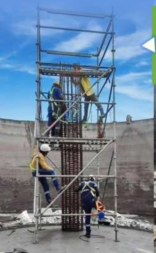
Para la respectiva intervención se realizó la demolición del mortero de nivelación, la instalación de la zapata y el amarre de acero de la columna.
