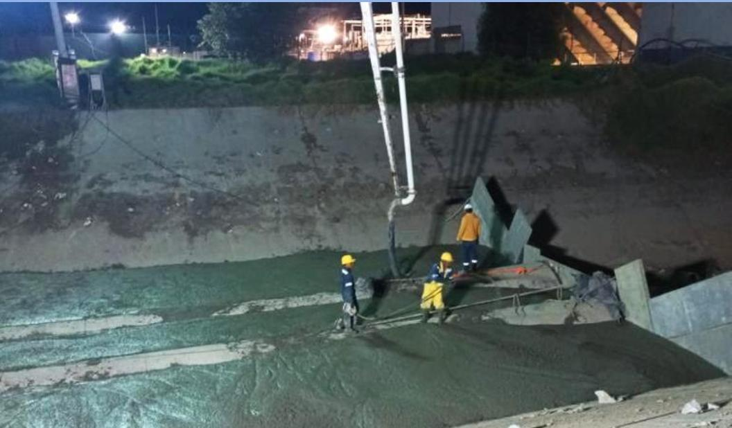
Paralelamente se fundió el muro final, ubicado en la parte superior de la tubería y se inició la construcción de las escaleras de acceso.
