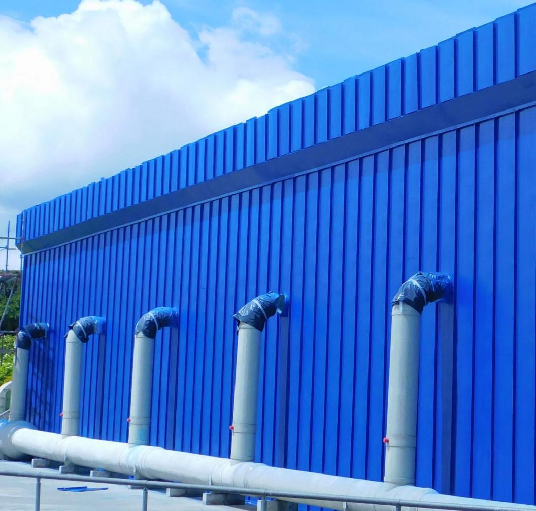
Se adelanta la etapa final de fabricación e instalación de las láminas de aluminio, remates, esquineros y acabados de la fachada del Edificio de Pretratamiento.
