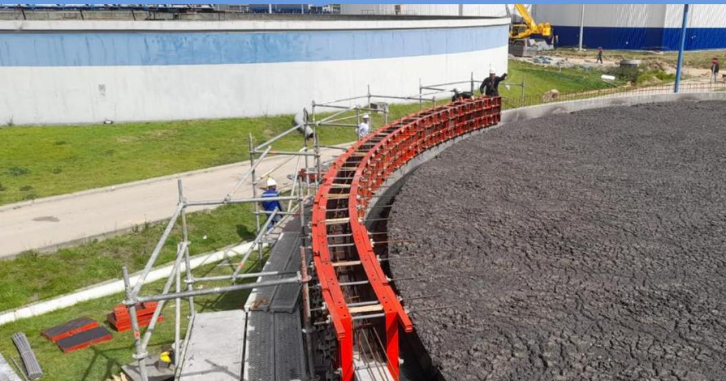
Se realizaron las perforaciones en los muros existentes para anclajes y la instalación de acero en el perímetro del espesador, esto con el fin de mejorar su desempeño y maximizar su operación.
