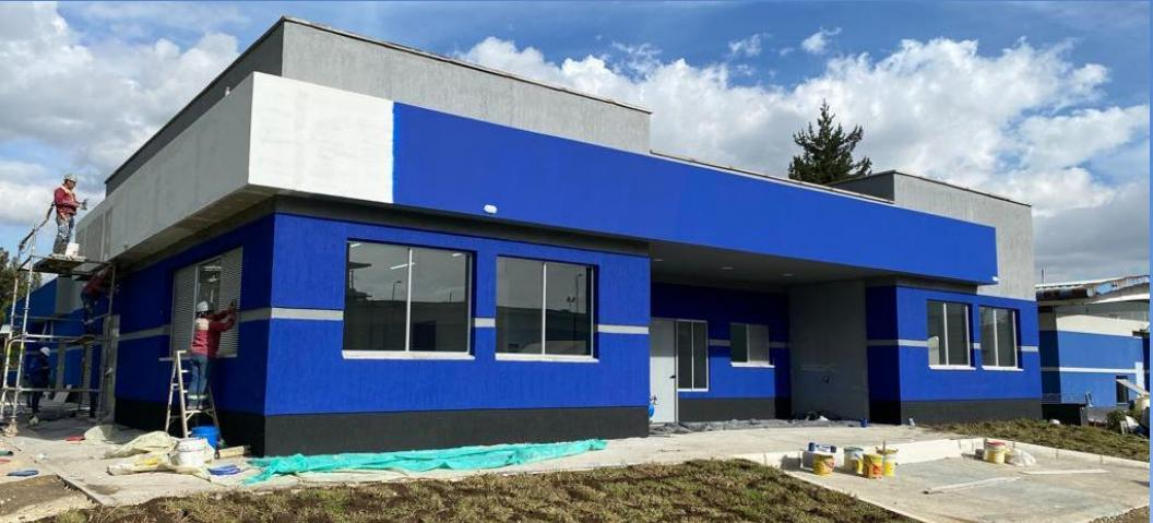
Se efectuaron los acabados finales del almacén, que involucraron la instalación de puertas, ventanas, pisos y pintura de la fachada. Además, se realizó la instalación de césped en los alrededores de este edificio..
