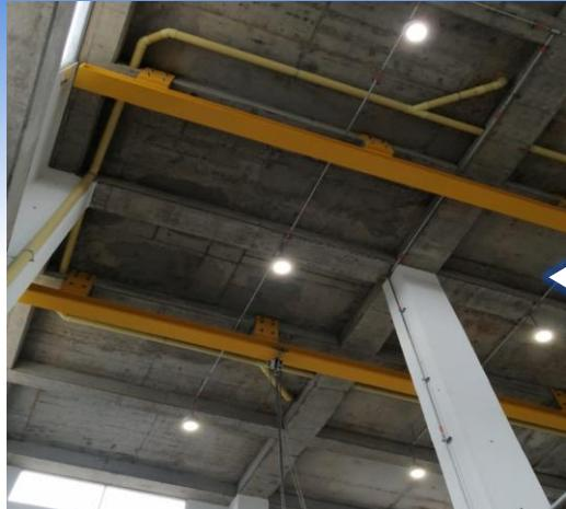
El montaje mecánico se entrega en un 100% con el armado, pintura de tuberías de la succión y descarga de bombas y el polipasto.
