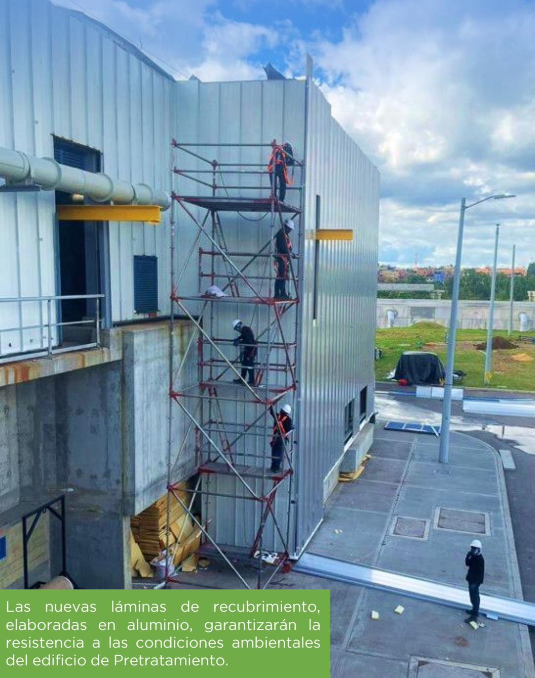
Las nuevas láminas de recubrimiento, elaboradas en aluminio, garantizarán la resistencia a las condiciones ambientales del edificio de Pretratamiento.
