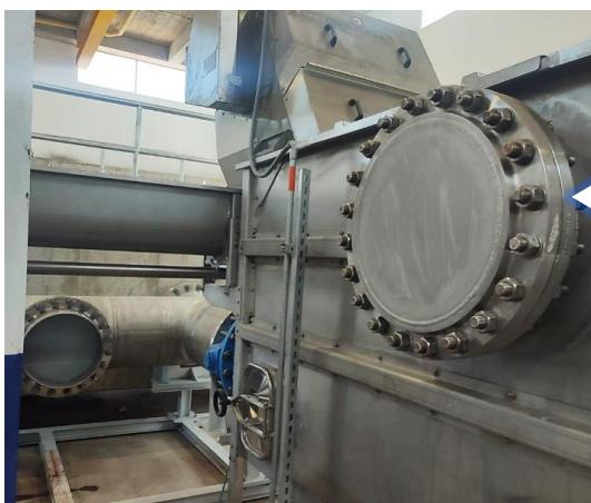
De igual forma se llevó a cabo el retiro de la conexión Bypass para garantizar el buen funcionamiento de la descarga de agua y de presión.
