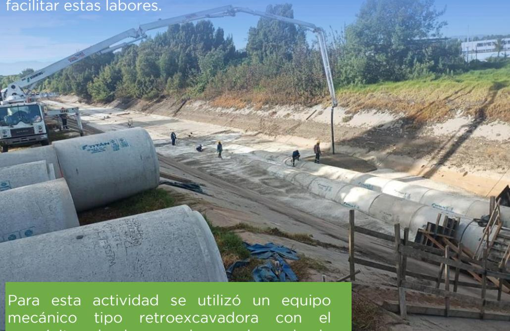
Para esta actividad se utilizó un equipo mecánico tipo retroexcavadora con el propósito de lograr el empalme de la tubería.
