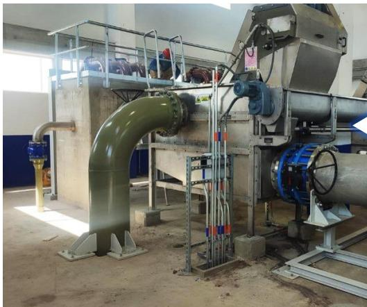
Finalizó el recubrimiento de las tuberías y soportería del Edificio de tamizado de lodos primarios.
