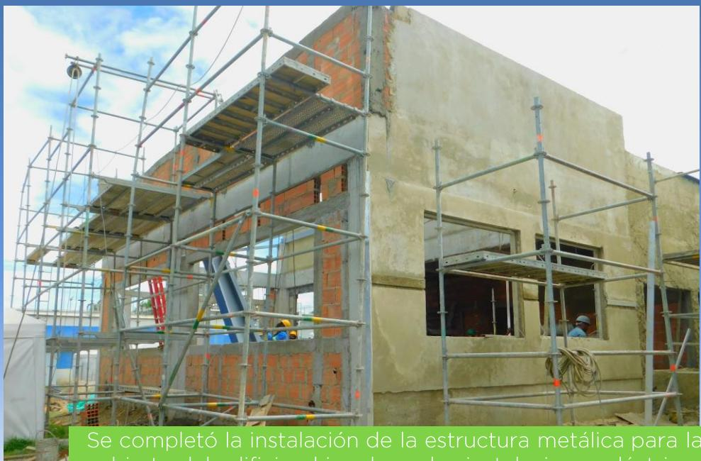
Se completó la instalación de la estructura metálica para la cubierta del edificio al igual que las instalaciones eléctricas junto con la infraestructura para la iluminación.
