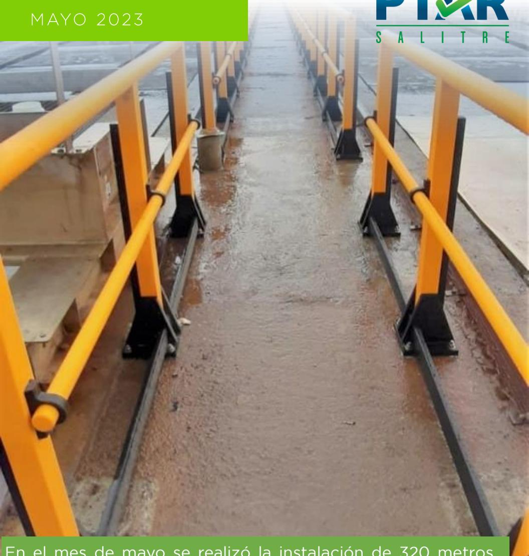
En el mes de mayo se realizó la instalación de 320 metros lineales de barandas en polipropileno con protección UV, en el área de los Desarenadores, cuya característica principal es que no se oxida, preservando así sus propiedades físicas bajo humedad permanente.
