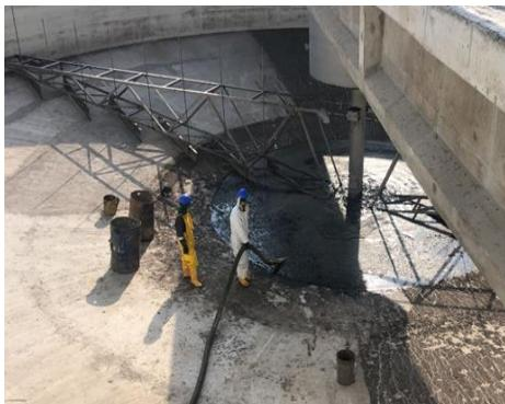
Una vez finalizada la prueba y verificados los niveles de la marca de agua, se llevó a cabo el vaciado del tanque con el apoyo de un vehículo de succión tipo vactor.
