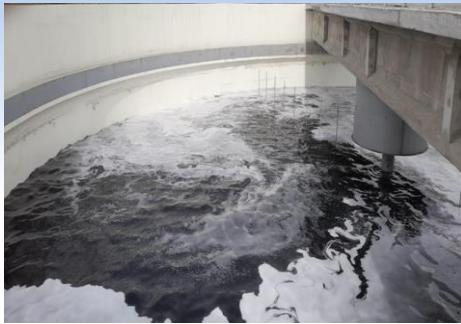
Se llevó a cabo el llenado del tanque con agua cruda, el cual tiene una capacidad de 2.000 m<sup>3</sup>. Este proceso se ha llevado a cabo para verificar la ausencia de fugas en la nueva estructura.
