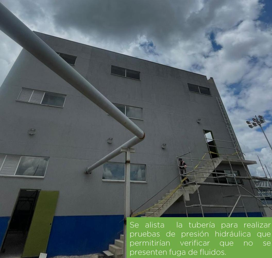
Se alista la tubería para realizar pruebas de presión hidráulica que permitirían verificar que no se presenten fuga de fluidos.
