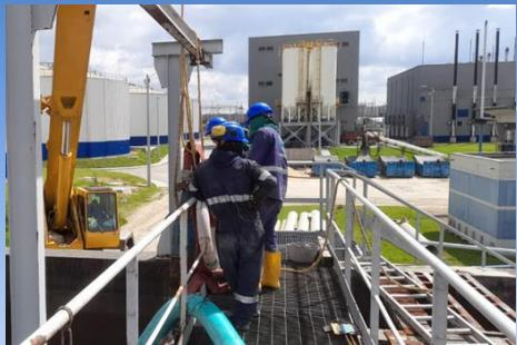
Se realizó la instalación de las bombas, para llenar el tanque espesador e iniciar la prueba de estanqueidad con agua cruda.
