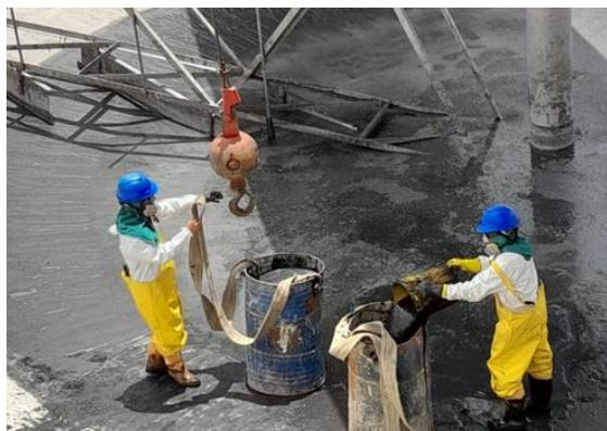
Se retiraron los lodos del tanque, dejándolo totalmente desocupado y listo para su entrada en funcionamiento una vez finalicen las actividades de conexión entre la fase I y la fase II de la PTAR El Salitre
