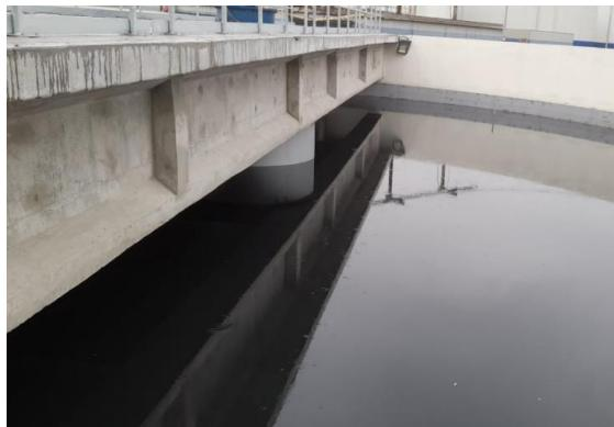
Después de verificar que la estructura no presentara fugas de líquidos, se procedió a vaciar el tanque usando bombas y mangueras.
