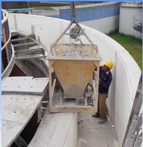
Se empleó un equipo mecánico tipo grúa para el transporte de materiales y retirar los escombros generados durante la demolición. Este proceso fue esencial para mantener un ambiente de trabajo seguro y limpio, garantizando un correcto desempeño y minimizando los riesgos de accidentes laborales.
