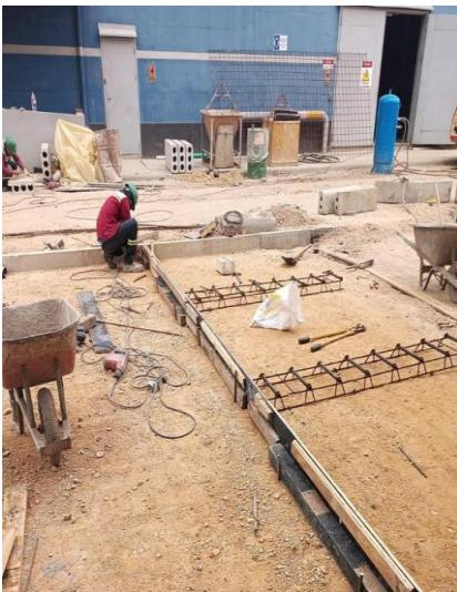
Proceso de adecuación del terreno, armado de la estructura y acabado final de la rampa de acceso al edificio.
