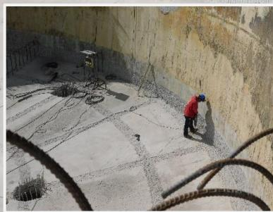
► Se realizó la demolición de la losa existente para la ubicación de los pilotes.
