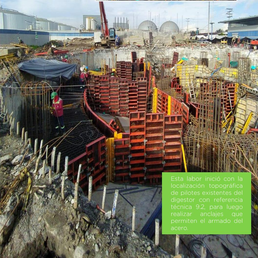
Esta labor inició con la localización topográfica de pilotes existentes del digestor con referencia técnica 9.2, para luego realizar anclajes que permiten el armado del acero.
