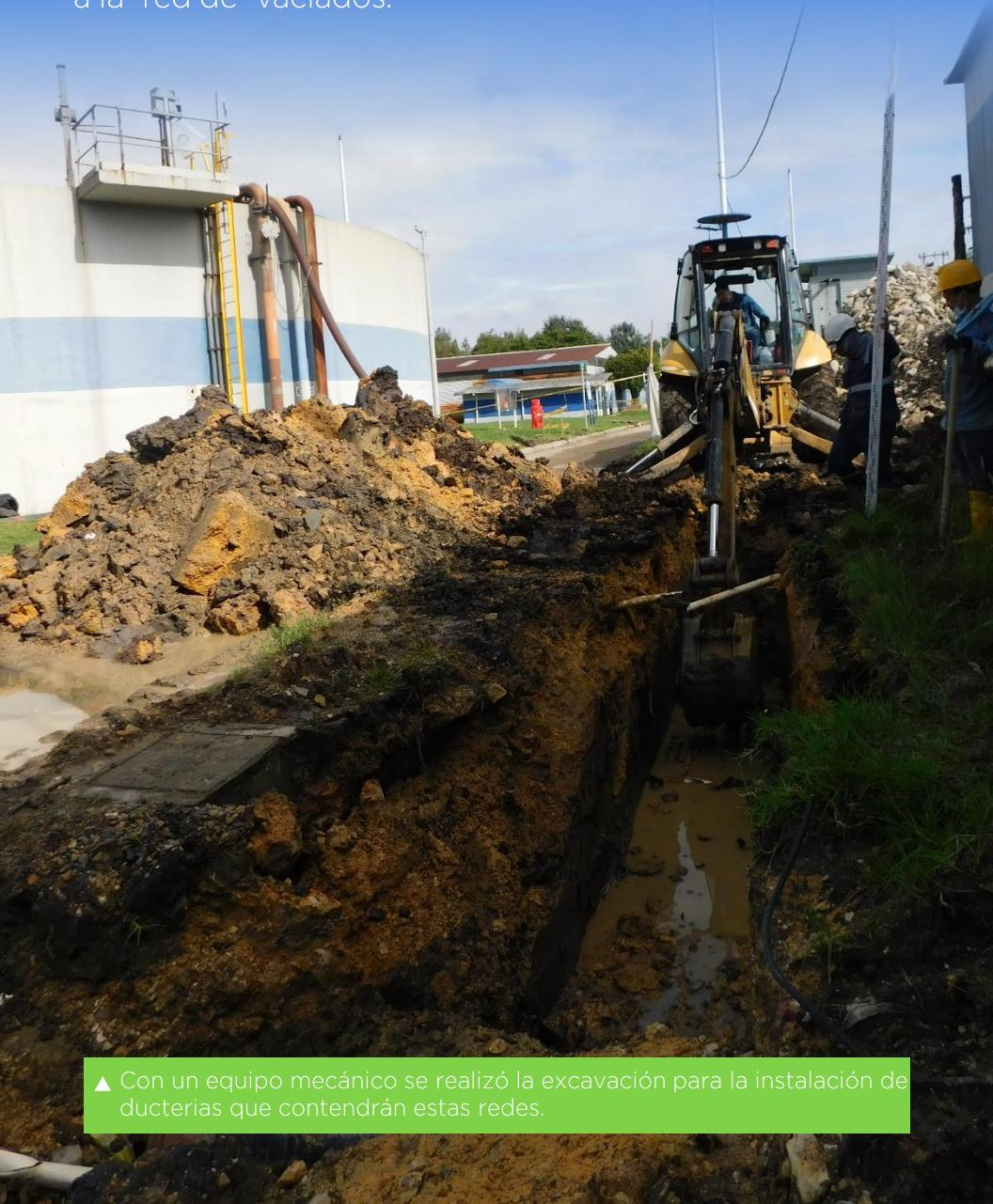
▲ Con un equipo mecánico se realizó la excavación para la instalación de ducterías que contendrán estas redes.
