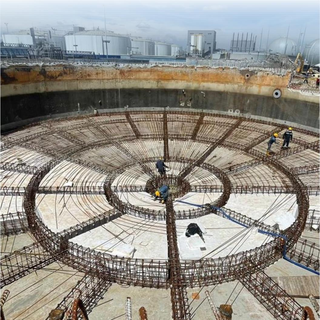
Instalación de casetón y armado de acero de refuerzo
