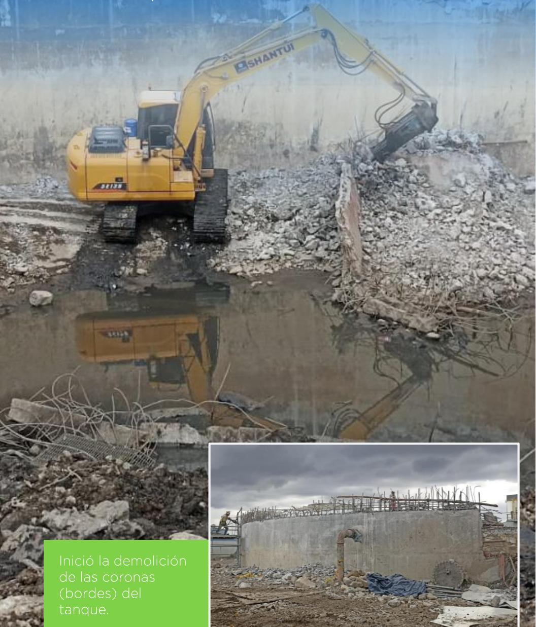
Inició la demolición de las coronas (bordes) del tanque.
