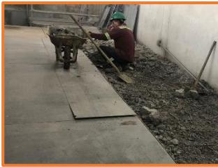
▲ Durante el mes de mayo se realizó la demolición de la losa en la parte interna para la ampliación del cuarto eléctrico
