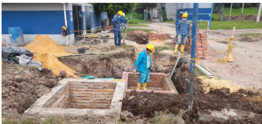
◀ Cajas de baja tensión y comunicaciones
