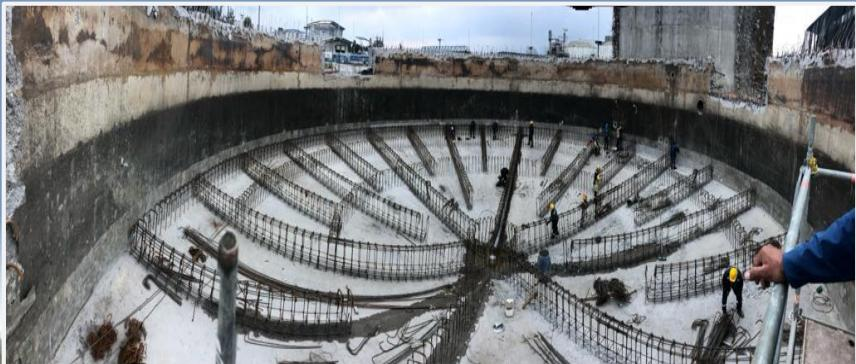
▲ Armado de acero y formaleta para vigas de cimentación.
