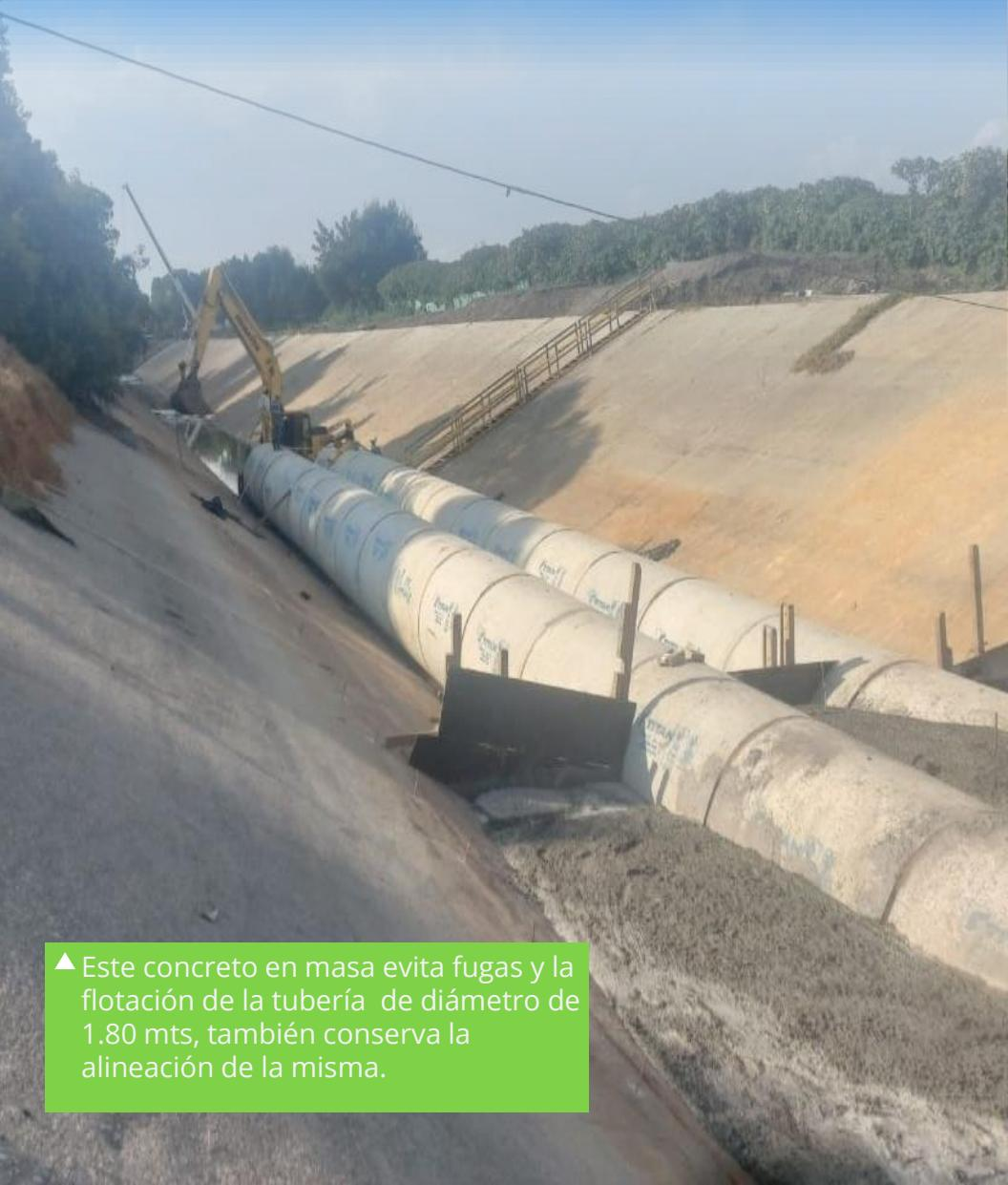
▲Este concreto en masa evita fugas y la flotación de la tubería de diámetro de 1.80 mts, también conserva la alineación de la misma.
