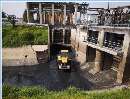
◀ Finaliza la extracción de lodos ubicados en Fase I, y retiro del tambre provisional, al igual que la extracción y desagüe de los lodos ubicados contiguo a los tornillos de Arquimides, para dar paso a las aguas por el interceptor 1B
