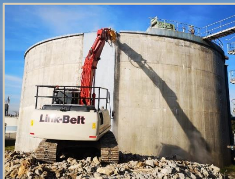
▲ Demolición del refuerzo estructural del digestor.
