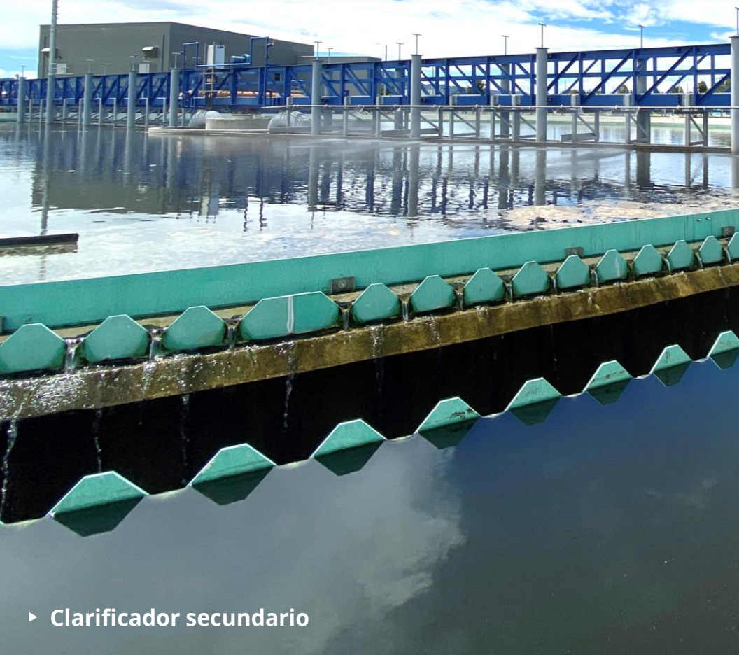
▲ Vista aérea del decantador secundario circular con doble vertedero
