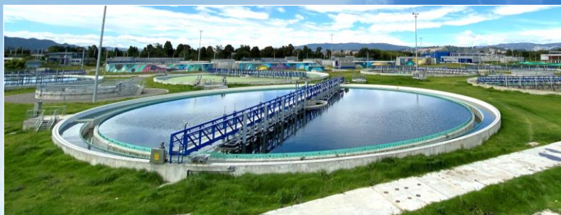
▲ Vista aérea del decantador secundario circular con doble vertedero
