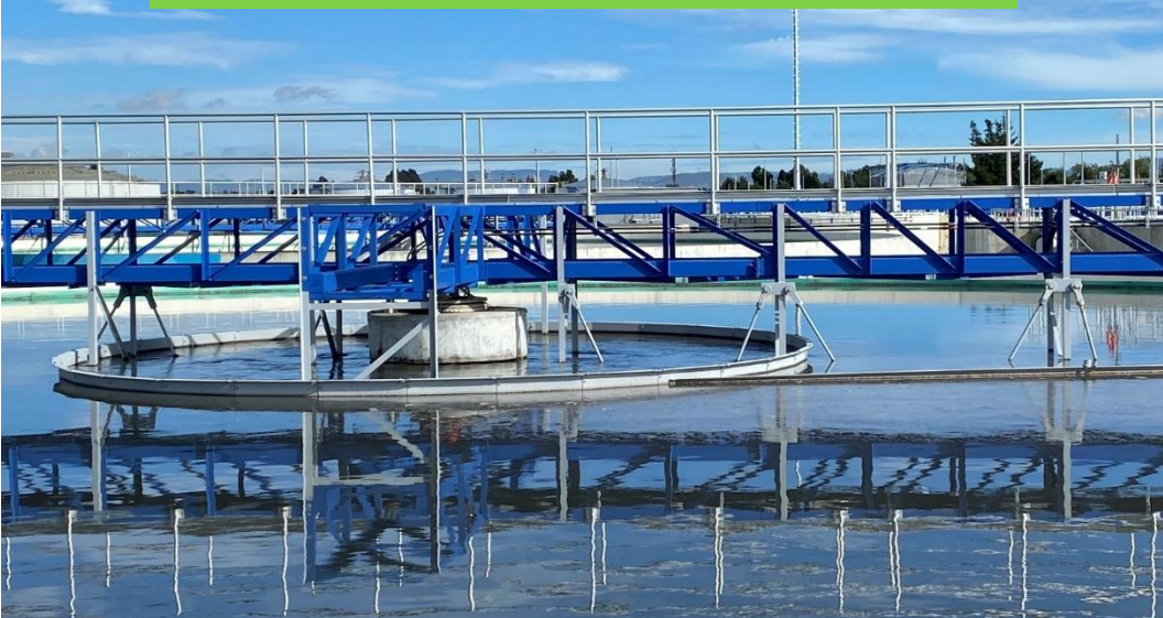
▲ Clarificador primario N° 1 y 2 en funcionamiento
