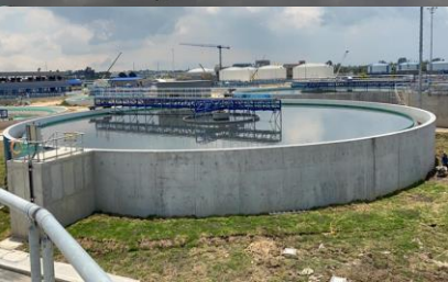
DECANTADOR PRIMARIO
