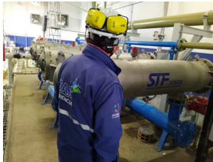
INSTALACIÓN AGUA SERVICIO FILTROS DE MALLA
