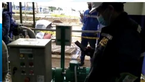
INSTALACIÓN AGUA SERVICIO FILTROS DE MALLA
