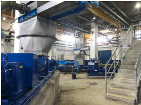
BOMBAS DE TORNILLO-LODOS
