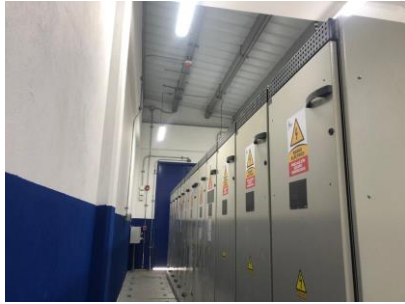
CCM AGUA SERV, POTABLE, INCENDIO
