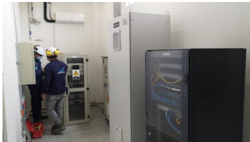
CCMS Y PLCs Bombes Lodos Primarios
