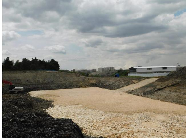
En el presente mes se continua con la construcción de la plataforma, mediante su revestimiento con piedra rajón y recebo, para garantizar una mejor resistencia. En esta etapa, las aguas residuales recibirán oxígeno por medio de difusores de aire.
