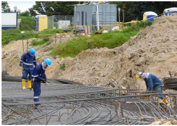
En este periodo se avanza en el armado del acero y posterior vaciado de concreto para la construcción de la losa de fondo (piso) de cada clarificador. Estos tanques se utilizarán para remover los sólidos contenidos en las aguas residuales como aceites, grasas y materiales flotantes.
