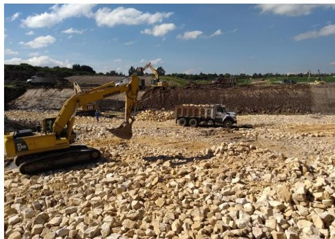
Se adelantan labores de relleno con piedra rajón, para conformar la plataforma de trabajo de las piloteadoras. Se avanza en la construcción de la viga guía y los muros de pantalla. Esta estructura es el lugar por donde ingresarán las aguas residuales provenientes del norte de Bogotá, las cuales recibirán tratamiento en la Planta.
