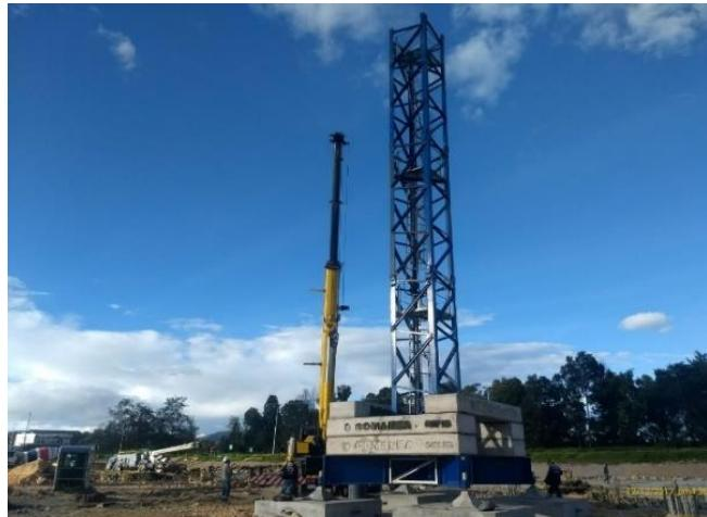
Los tanques de clarificación primaria, se utilizarán para remover los sólidos contenidos en las aguas residuales. Al finalizar el periodo se ejecutó el 100% de la cimentación que soporta esta estructura, se adelantó la limpieza de los cabezales sobre los pilotes, la adecuación de la losa de fondo y la instalación de la torre grúa para la etapa de construcción de estos tanques.
