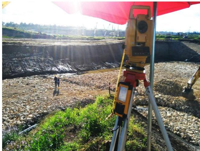
El avance de excavación para la conformación de esta estructura se encuentra en un 75%. Se realizó la instalación de rajón y triturado para la conformación de la plataforma de las piloteadoras. De igual forma, se adelantan actividades de cimentación y fundida de pilotes.
