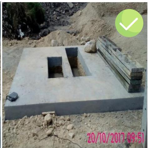
Se continua con la construcción del cárcamo para la instalación del transformador 300KVA. Se realizan trabajos específicos en acabados para la caja del transformador de 220 KVA.
