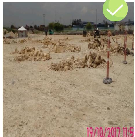
Para el presente mes y debido a las últimas precipitaciones, fue necesario realizar mantenimiento a la plataforma, así como a la rampa de acceso, pues se presentaron inconvenientes con el ingreso de vehículos para el descargue de concreto. Continúan las actividades de excavación y pilotaje.
