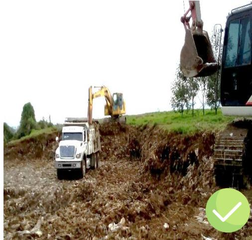
Iniciaron las actividades de excavación, replanteo y nivelación del terreno para la construcción de la plataforma que soportará los tanques de aireación. El material de excavación es trasladado al área prevista para la construcción del Parque Metropolitano PTAR Salitre.
