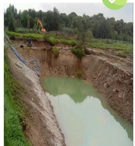
Se realizó el aprovechamiento forestal de los árboles aislados (acacias) que se encontraban emplazados en zona aledaña a la estructura de captación de las aguas. Se continua con el bombeo de las aguas producto de las fuertes lluvias y nivel freático, así como el trazado para la construcción de la rampa de acceso.
