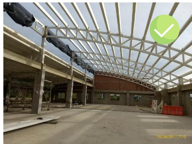
El Edificio de Gerencia presenta un avance del 62%. Específicamente, se continuó con la instalación de la mampostería, construcción de andenes perimetrales e instalación de la cubierta.
