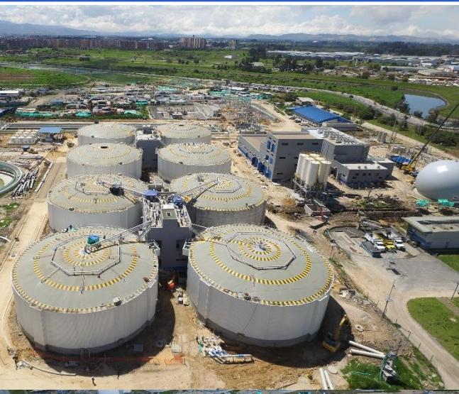
Se llenó completamente el tanque para dar inicio al proceso de trasvase de lodo desde la fase 1 y quedó finalizada tanto la instalación de tuberías de agua, gas y lodo con sus respectivas pruebas como el vaciado de grout de barandas y resane de concreto en la superficie exterior.
