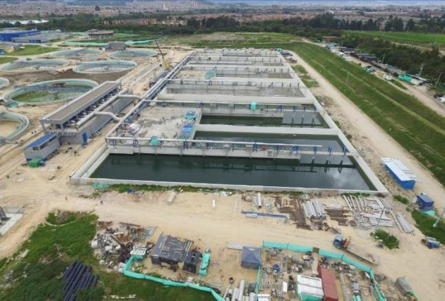
En el tanque biológico N° 2 se instalan las compuertas de la alimentación escalonada, las vigas de los soportes de las bandejas eléctricas junto con la preparación de biseles, conformado de tubería, soldadura de juntas y accesorios de línea de aireación
