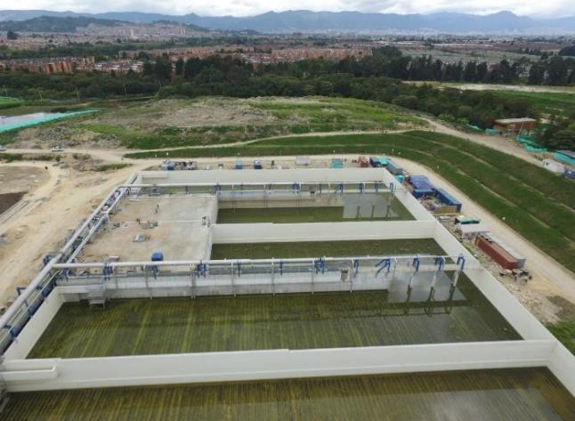
En el tanque N° 4 se realiza la prueba de las parrillas de difusores, se realiza la instalación de la lámina del vertedero, la soportería de la línea de vaciado, soldadura y el ajuste de tuberías de líneas de aireación hacia difusores.
