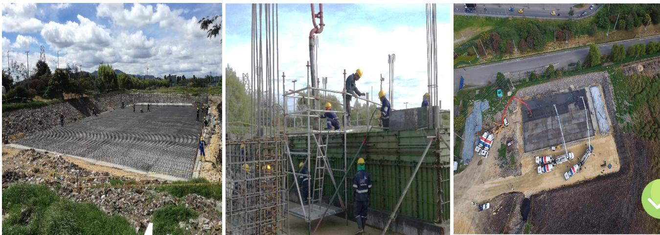
Se alcanzó el 44% de avance en la construcción del Edificio de Gerencia. Se realizó el amarre de acero e instalación de formaleta y se descargaron 56.5 metros cúbicos de concreto para la conformación de los muros, así como la instalación de losas alveolares que corresponden al sistema de entrepiso para empleado para esta estructura.
