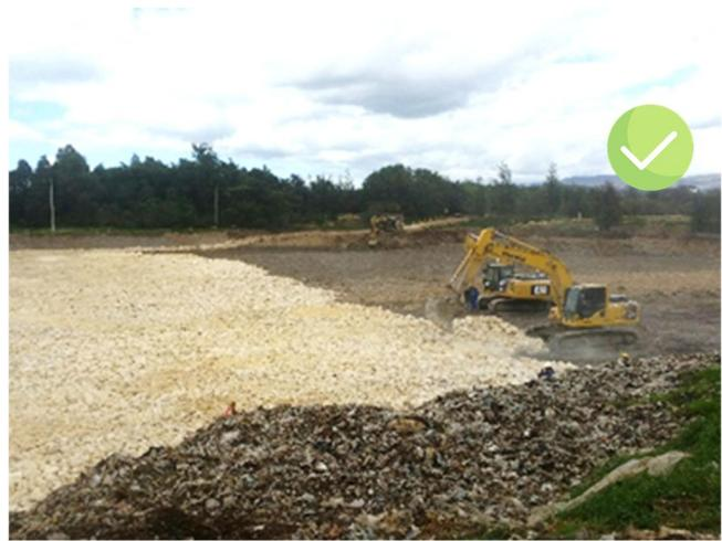
En este sitio se ubicarán seis (6) decantadores primarios; se iniciaron actividades de excavación de terreno conformado por basuras, retiro de arcilla, y posterior mejoramiento del suelo con la instalación de una capa de piedra rajón de 40 cm y una capa de recebo de 10 cm de altura, de conformidad con las recomendaciones del Especialista en Geotecnia. Próximamente iniciarán los trabajos de cimentación (pilotaje).
