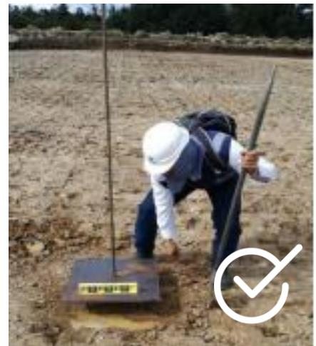
Esta actividad se encuentra en un **60%** de avance y tiene como finalidad instalar equipos de monitoreo para predecir la evolución del terreno frente a las cargas que deberá soportar la Ampliación y Optimización de la Planta, así como los sectores aledaños. Se lleva un registro de las pruebas y ensayos, datos que posteriormente son procesados y analizados, para interpretar el comportamiento del terreno y tomar medidas correctivas, en caso de requerirse.
