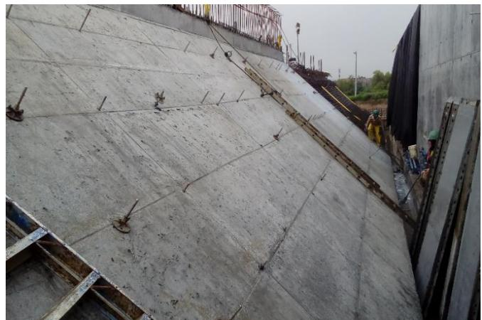
En abril, se avanzó en la fundida de los muros verticales e inclinados del desarenador, se realizó la excavación de la arqueta de salida y se dio inicio al armado de acero necesario para esta estructura.
