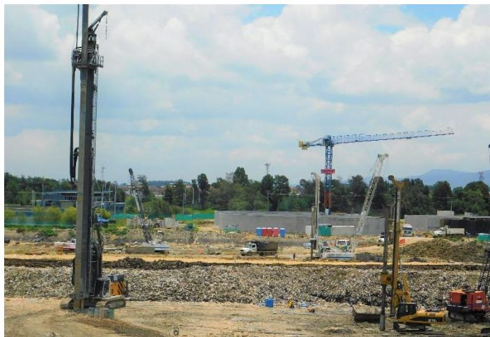
Durante abril, se continuó con la excavación mecánica, así como con la ejecución de los pilotes y descabece de los que ya se encuentran fundidos.
