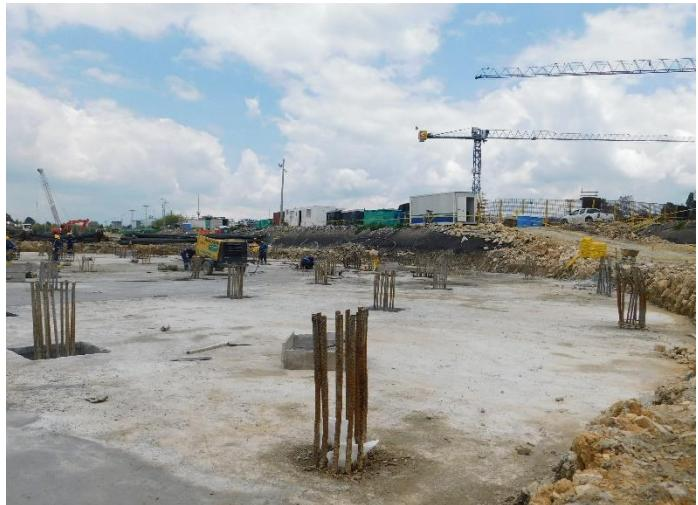
En este periodo, continuaron las actividades de ejecución de pilotes y descabece de los que ya encuentran fundidos, así como las labores de excavación y adecuación de solado (concreto de limpieza). De igual forma, se dio inicio al armado de losas de fondo de los tanques.
