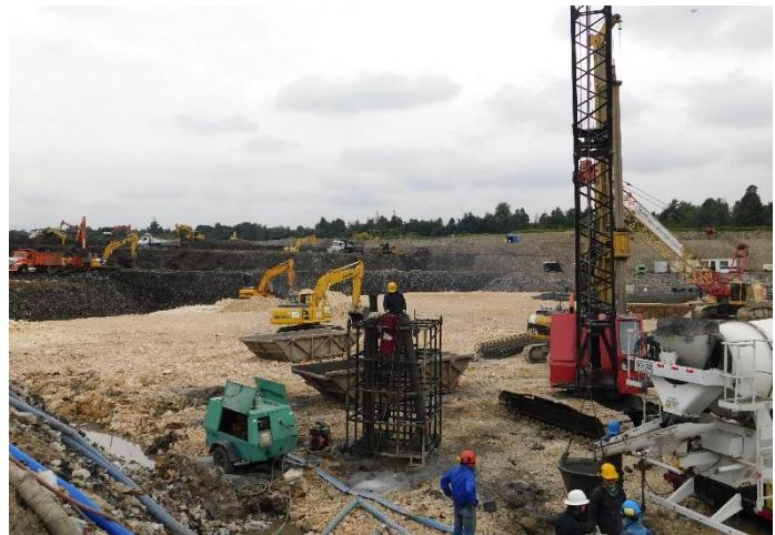
En el presente período se continúa con la ejecución de la cimentación profunda mediante pilotes de concreto con acero de refuerzo para las estructuras de los tanques en los que se adelantará el proceso de aireación de las aguas residuales que serán tratadas por la PTAR El Salitre Fase II.
