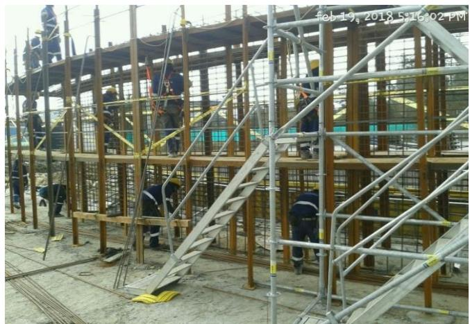
Para el presente período, se continuó con el tendido y armado de acero para las seis losas de fondo de los tanques y el vaciado de concreto, se inicia además con los trabajos de pre-armado de acero de muros y fundida de los mismos.
