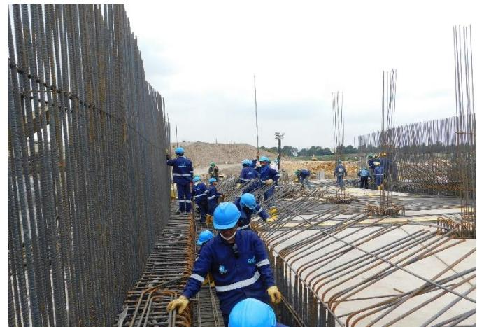
En el presente período se continúa con la excavación y fundida de las pantallas del edificio de Pretratamiento. Se avanza con las actividades en el descabece de pilotes en el área del desarenador, iniciándose además las labores de tendido de aceros para cimentación y muros en esta estructura. Adicionalmente, se está trabajando en los edificios aledaños al Pretratamiento realizando la cimentación profunda mediante pilotes.
