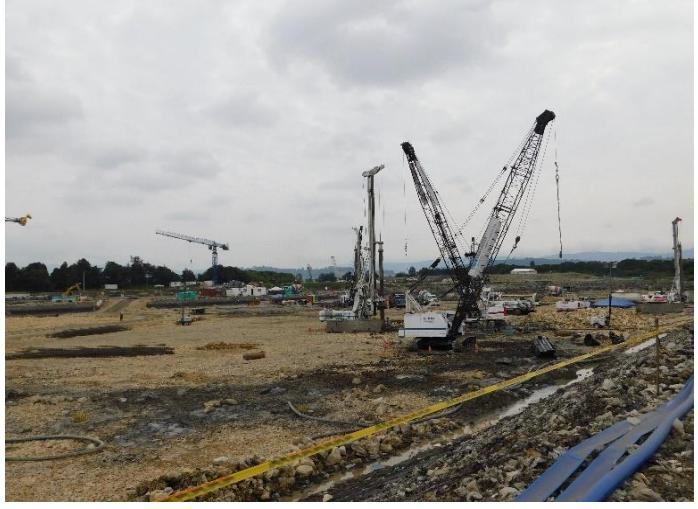
En el mes de febrero se continúa con el armado de acero, excavación y fundida de pilotes, proceso de cimentación de las nuevas estructuras que hacen parte del proyecto de Ampliación y Optimización de la Planta de Tratamiento de Aguas Residuales El Salitre, las cuales se encargarán del retiro de sólidos en suspensión que se convertirán en lodo.
