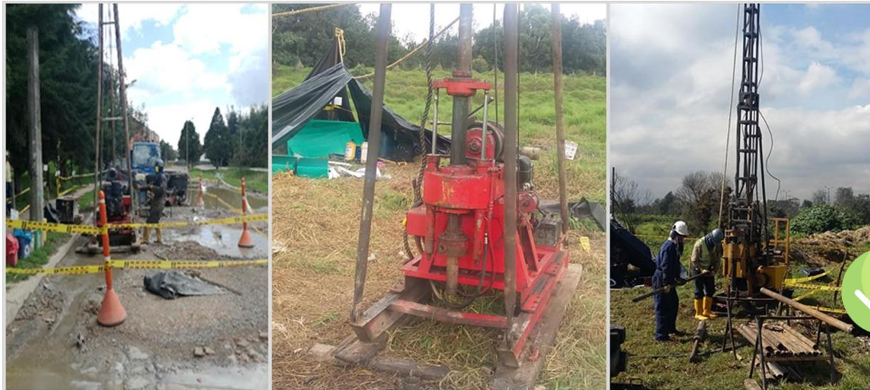
Consisten en el reconocimiento de las características del terreno mediante sondeos mecánicos y la posterior interpretación de los datos obtenidos. Esto permitirá caracterizar los diversos suelos presentes en el predio destinado para la ampliación y precisar el tipo de cimentación requerida.
